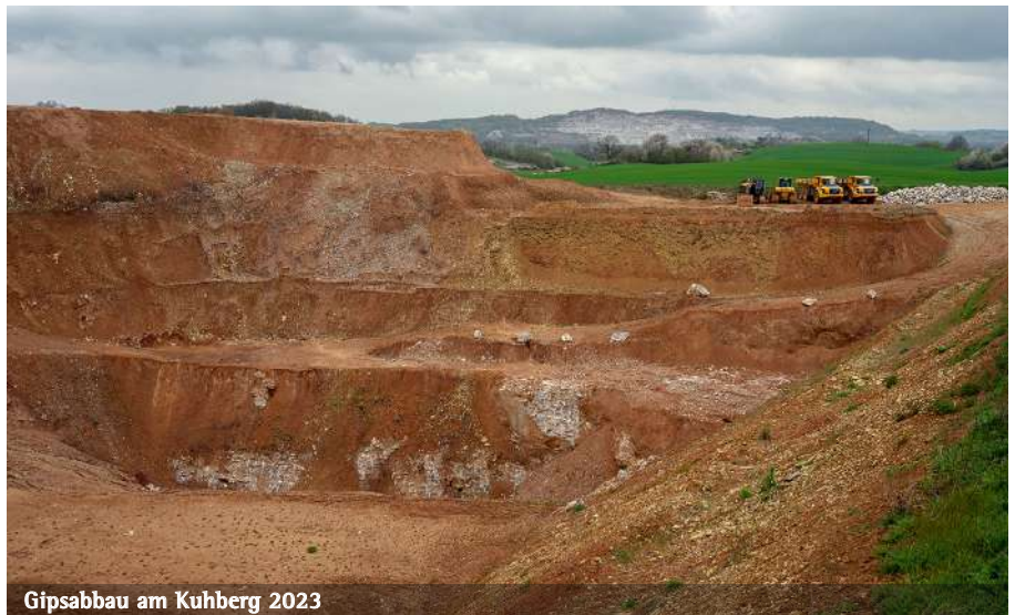
Gipsabbau am Kuhberg 2023
