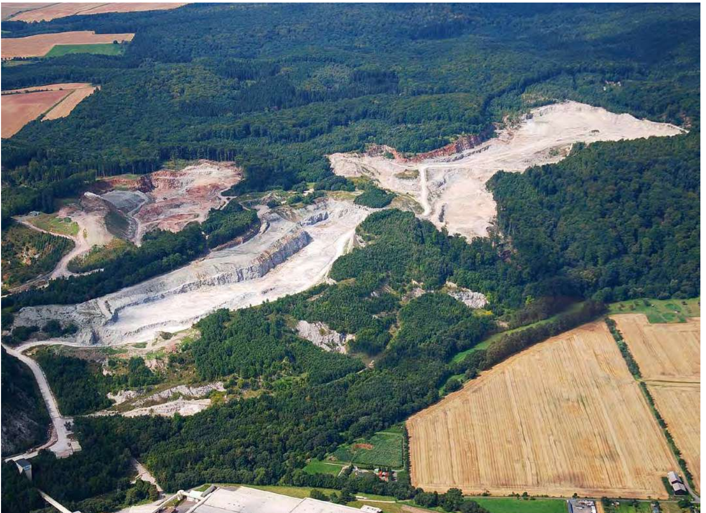
Der gigantische Tagebau im Alten Stolberg zerstört naturnahe Laubwälder voller Karsterscheinungen. Seit 2014 (Foto) ist der Abbau weiter fortgeschritten
