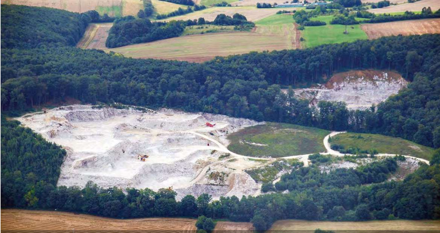
Der Tagebau Rüsselsee (im Vordergrund) wurde bei Genehmigung von der zuständigen Raumordnungsbehörde als „nicht raumrelevant“ eingestuft. Rechts hinten der Abbau Himmelsberg. Eine Ausweitung beider Tagebaue in alle angrenzenden Waldbestände findet aktuell statt (Foto von 2014).
