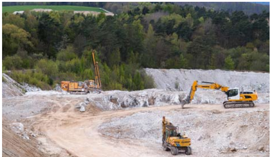
Zwischen dem Abbau Ellricher Klippen (vorn) und Pontelberg (hinten) könnte das Grüne Band verschwinden
